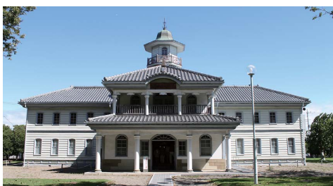
敷地内にある旧水海道小学校
