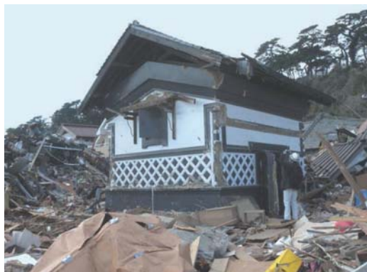
津波で被災した本間家土蔵（提供：佐藤敏宏）
